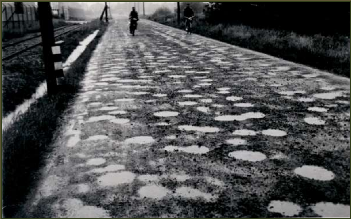
Stallbackavägen - som kallades Hålvägen - innan den asfalterades. Foto år 1940.
