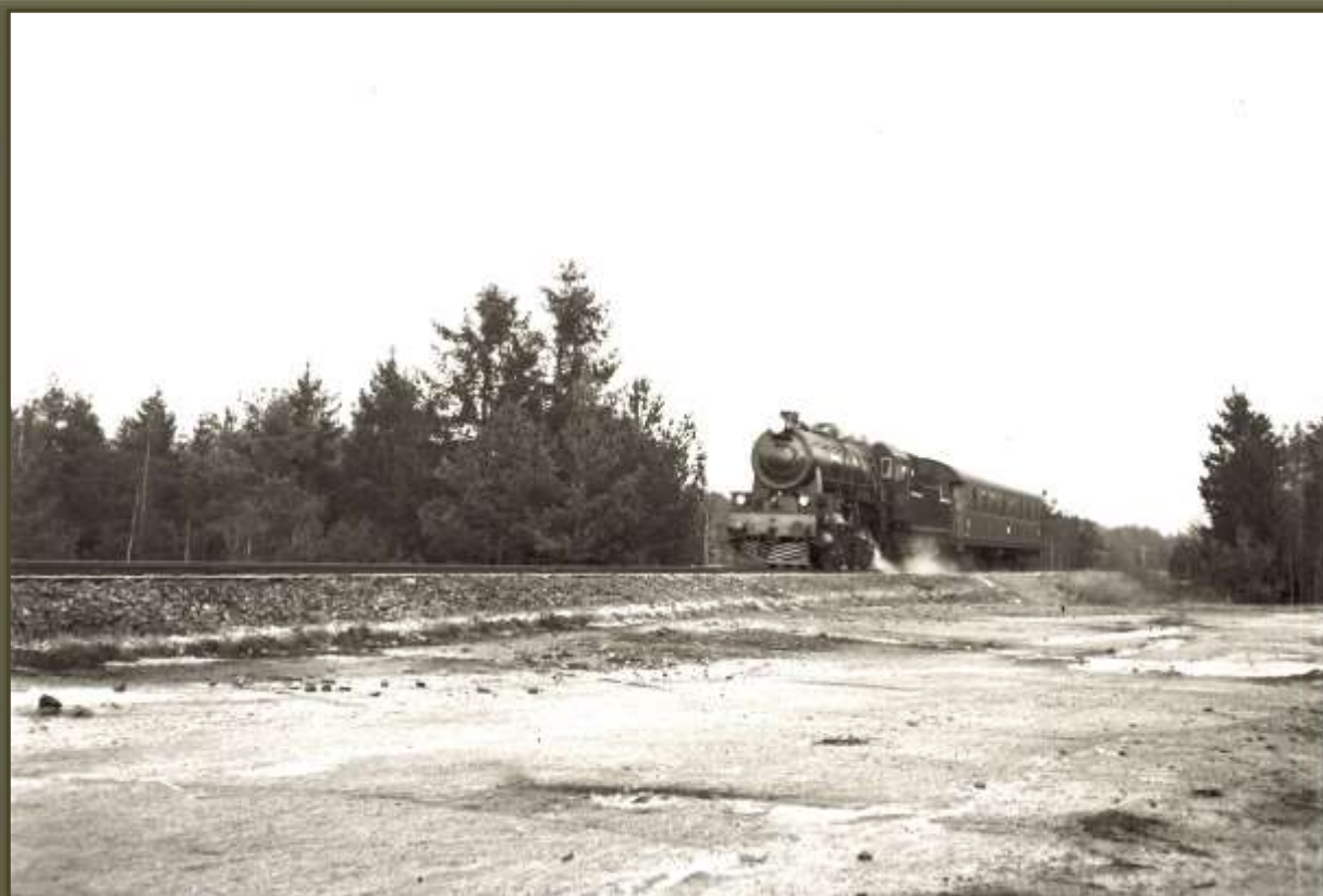
Nohabs järnväg på slättbergen.
