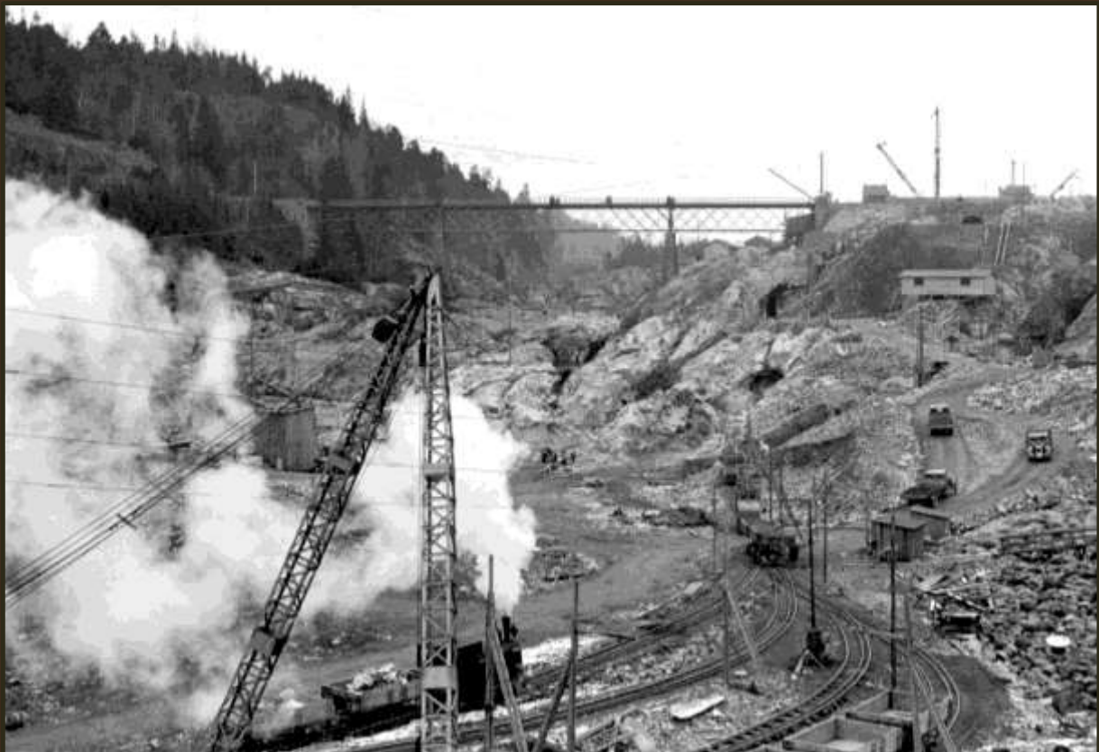
Hojumstationen under uppbyggnad i februari 1939.
