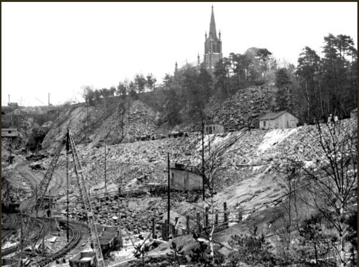
Hojumstationen under uppbyggnad i februari 1939.
