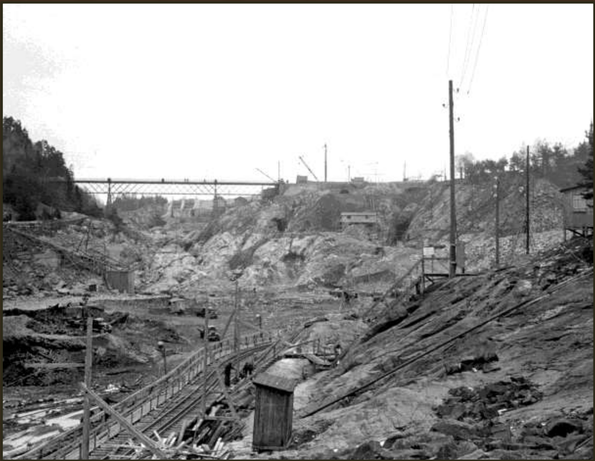
Hojumstationen under uppbyggnad i februari 1939.
