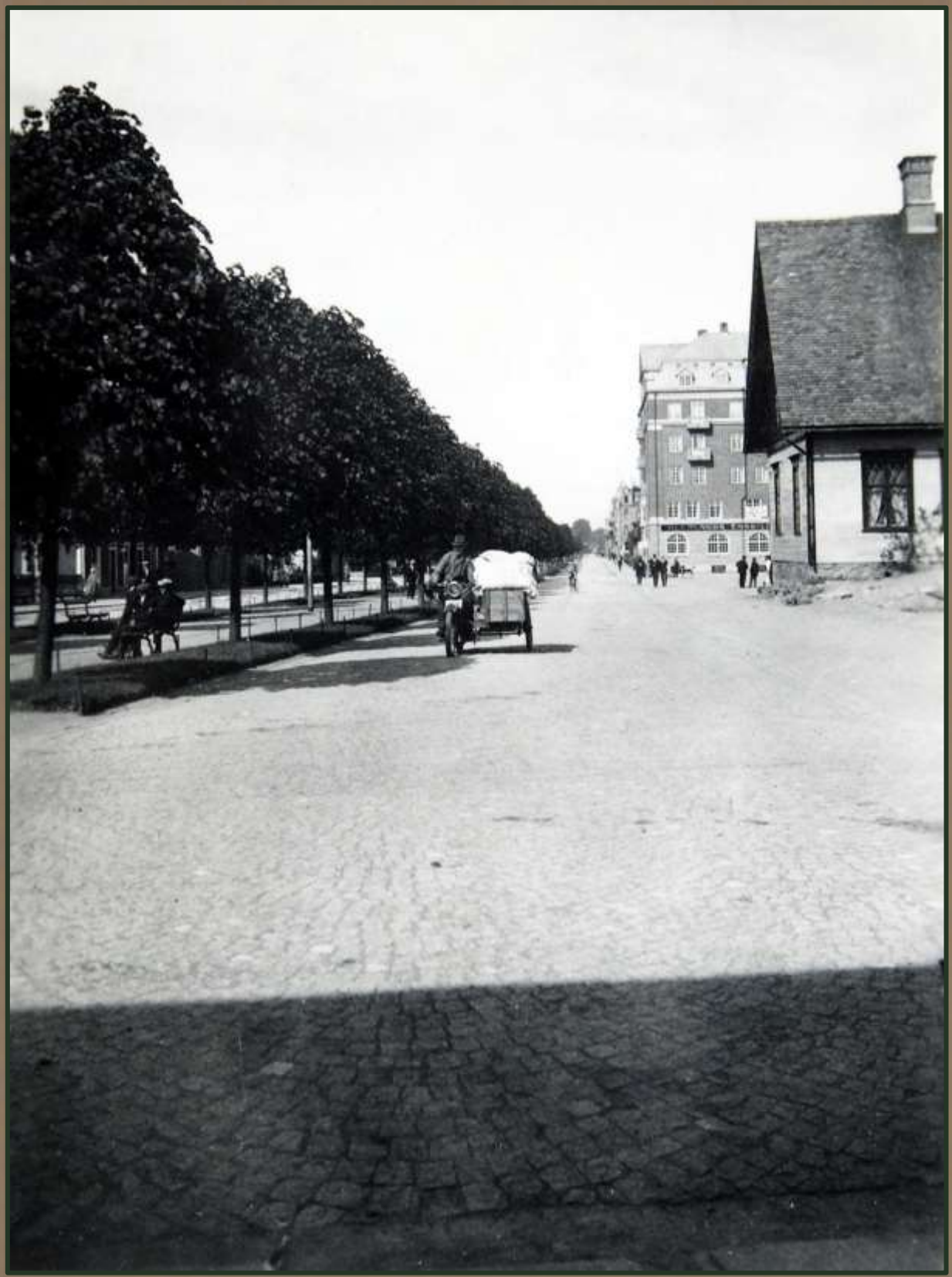
Kungsgatan mot norr. Flickslöjdskolan närmast till höger.
