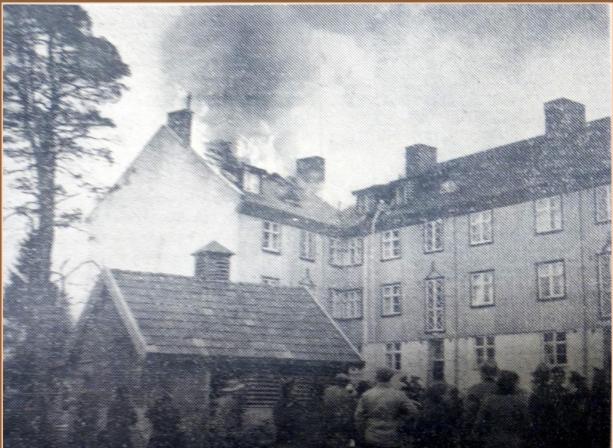
Gårdssidan av den brinnande byggnaden.
